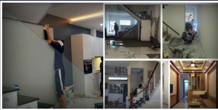
Sửa Chữa Cải Tạo
